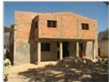
Kein Rohbau, sondern eine Kirche voller Leben
